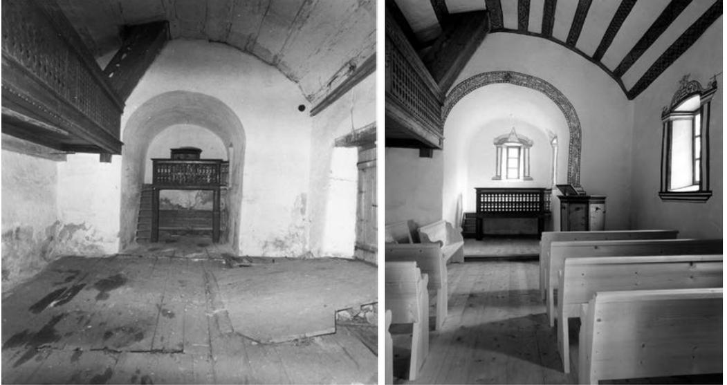
**Bild 3a/b: Blick ins Innere vor und nach der Renovierung. Zu erkennen ist das Orgelgestühl, auf dem wohl ursprünglich der Fürsinger, später dann die Orgel stand. Es wurde im Rahmen der Renovationsarbeiten eingekürzt, um das dahinter liegende Fenster wieder sichtbar zu machen.**
