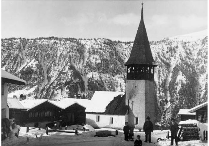
**Bild 2: 1888 wird in der Kirche ein Ofen eingebaut. Auf dem Bild zu sehen ist das Kaminrohr, das den Rauch aus dem Innern führt. Um den Ofen aufstellen zu können, wurde die Kanzel auf die andere Seite der Kirche verschoben. Das Bild zeigt auch noch die Umrisse der Schalllöcher in Form von Rundbogenfenstern.**
